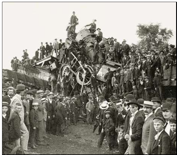
Obr. 7.1 Příklad 7.1. Následky srážky lokomotiv v roce 1896
