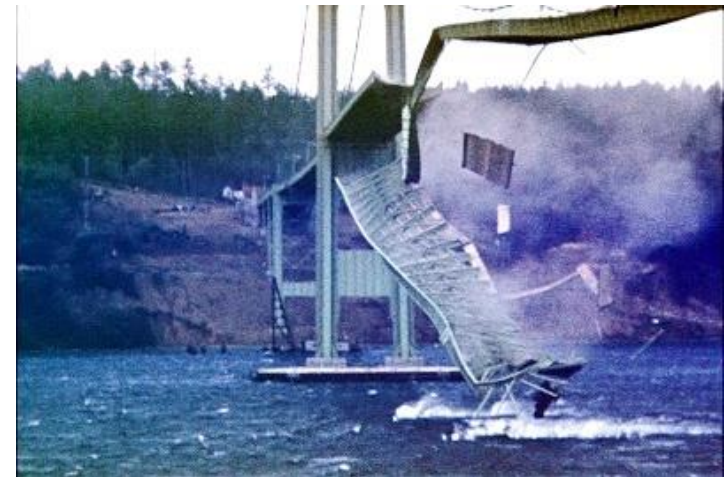
Tacoma Narrows Bridge v roce 1940 se zřítil v důsledku torzních kmitů, které vznikly rezonancí mostu s nárazy větru
